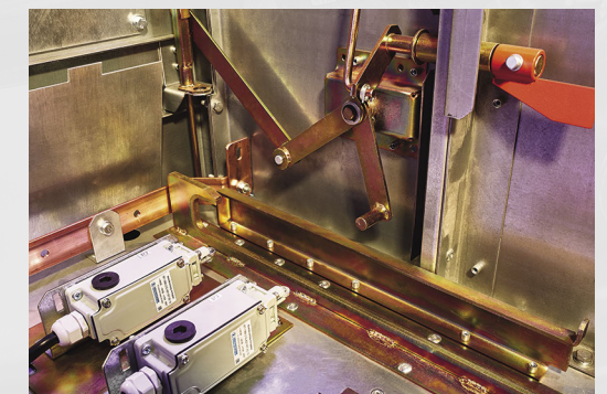
Рис. 3.15. Часть блокировочного узла вката ВЭ
